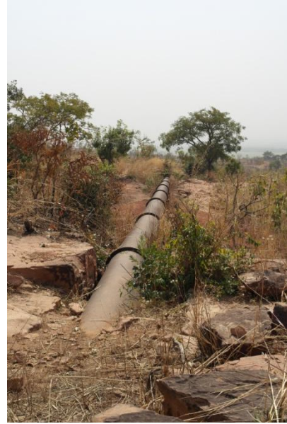
1970년대 설치한 농업용수용 파이프
